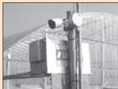
防犯カメラの設置
