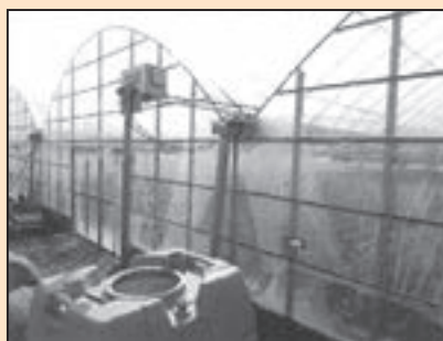
防犯カメラの設置
